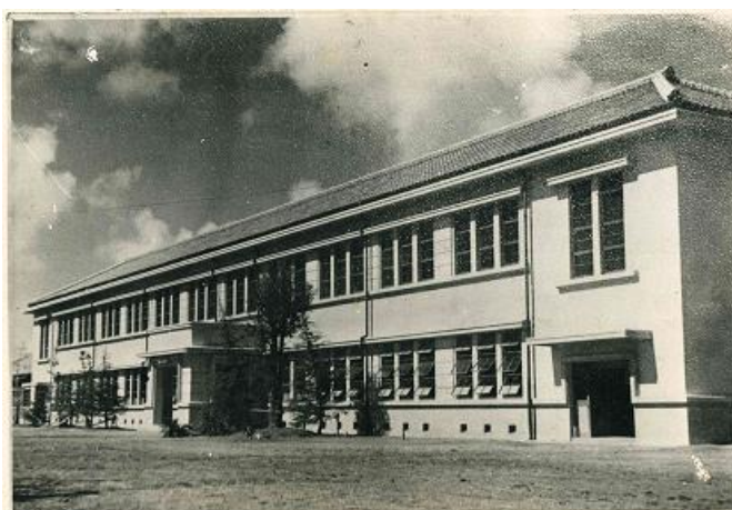
昭和11年3月竣工の鉄筋コンクリート校舎
