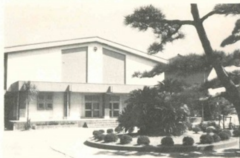
厩内運動場 (昭41. 3. 28竣工)
